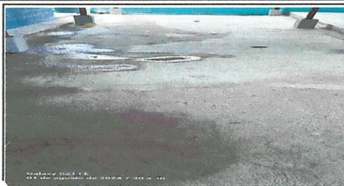
Foto 1: MÓDULO 1 FUNDICIÓN NUEVA LOSA
