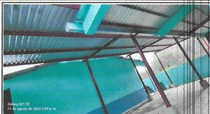
Foto 2: MÓDULO 1 TECHADO DE PATIO
